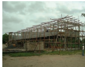
Progression des travaux - Juin 2006
