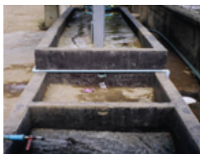
Les lavabos existants
