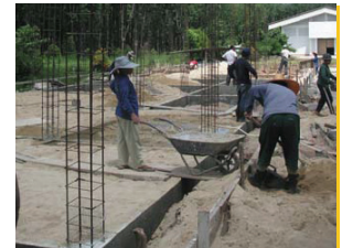
Début des travaux
