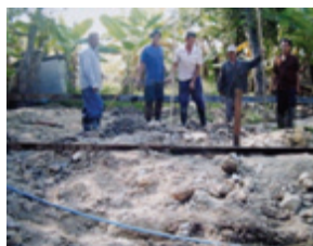
Le début des travaux
