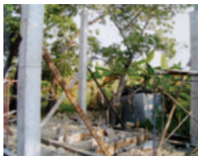
La pose des piliers porteurs
