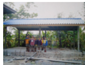
Les enfants - Témoins de la mise sous toit
